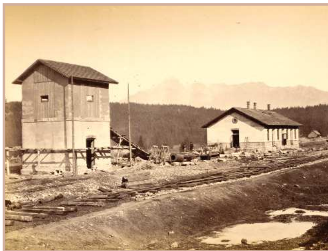
Prijímacia budova IV. triedy v stanici Východná
