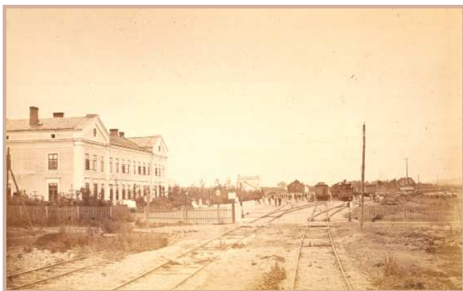
Plotom ohraničená železničná stanica Bohumín
