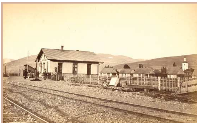
Železničná stanica Kysucké Nové Mesto s prijímacou budovou najmenšej (V.) triedy
